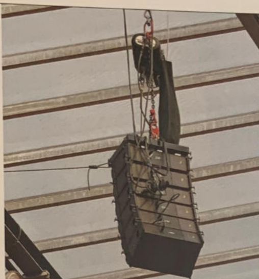
Für die Beschallung der Oberränge sorgten nach der Einholung eines Statikgutachtens acht Arrays aus jeweils sechs dV-DOSC-Einheiten, die von erfahrenen Riggern in 32 Meter Höhe unter dem Stadionsdach montiert worden waren.
